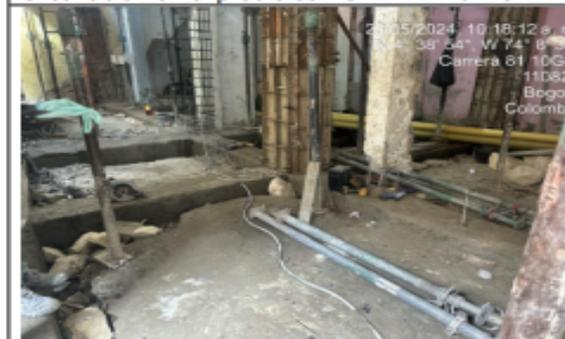
**Fotografía 6.** Construcción de columnas, presencia de formaletas en el predio con CHIP AAA0148KYKC
